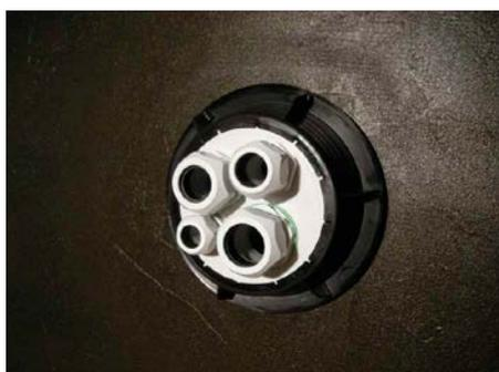
4. Inserire HL 801 Adattatore per passaggio-tubi, completo di giunti filettati, nell'impermeabilizzazione per tubi (HL800) già preparata, stringere il dado di sicurezza di HL800.
