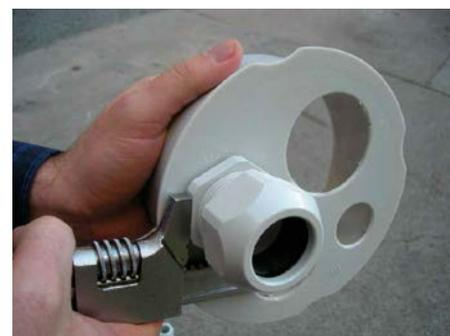
3. Montare i giunti filettati sull'adattatore per passaggio-tubi e stringere i dadi
