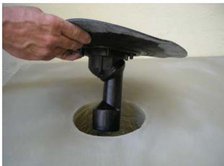
1. Alloggiare il corpo di scarico con protezione per il cantiere nell'apertura della soletta
