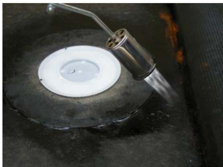
2. Saldare il collare bituminoso dello scarico con il telo bituminoso del fabbricato
