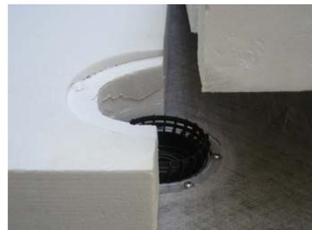
3. Stendere lo strato di separazione, applicare l'anello di drenaggio (HL180) sul corpo di scarico, posare la coibentazione
