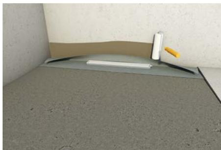
7. Applicare sul vello, fornito dalla fabbrica, del mastice impermeabilizzante da ambo le parti
