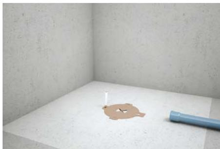
1. Definire la direzione dello scarico, posizionare la dimo in direzione dello scarico e segnare i punti dei fori per il fissaggio
