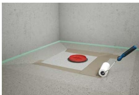
8. Impermeabilizzare tutta l'area doccia anche in prossimità dello scarico passando sopra e sotto il telo di impermeabilizzazione
