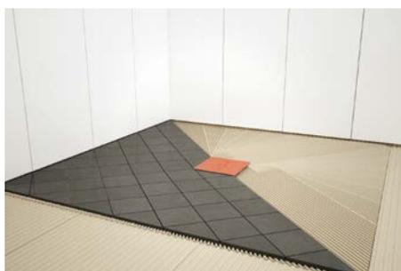
10. Posizionare la direzione dell'estensione (può ruotare di 360°) in base al disegno delle piastrelle
