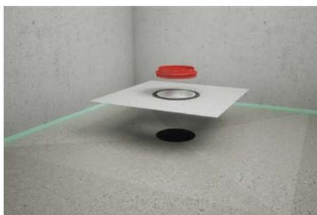
7. Collegare il kit di impermeabilizzazione e il tappo di copertura cantiere tra loro e riposizionare tutto sullo scarico
