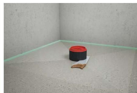
6. Una volta che il massetto si è asciugato tagliare la parte eccedente della copertura in plastica
