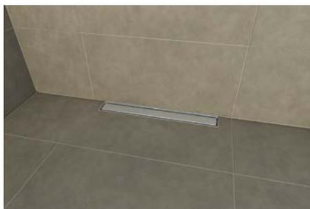
10. Togliere la copertura protezione, siliconare le fughe di connessione
