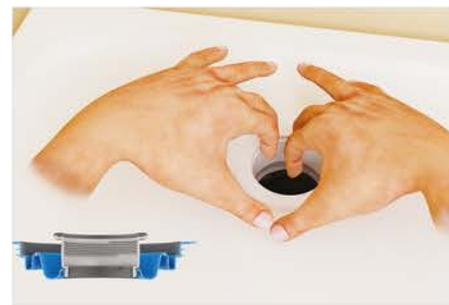
15. Connessione dell'elemento flessibile con il controdado.
