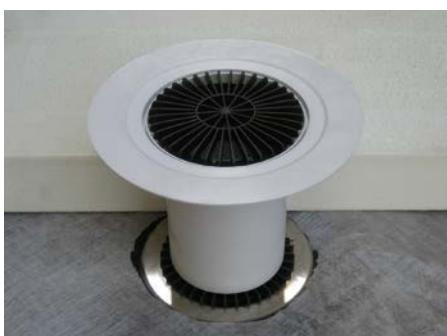
8. Postaviti termoizolaciju, podešiti visinu nastavnog elementa i ukoliko je potrebno pilom skratiti nastavni element
