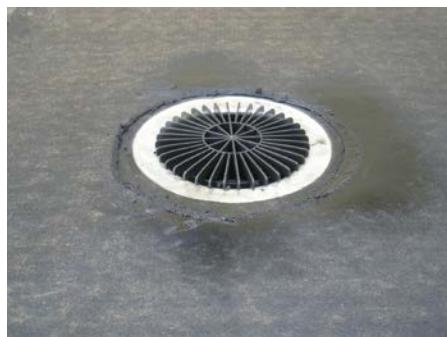
5. Stručno povezivanje slivnika u dvoslojnu bitumensku hidroizolaciju!
