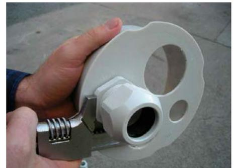
3. Verschraubungen und Rohrdurchführung verbinden, Verschraubungen festziehen
