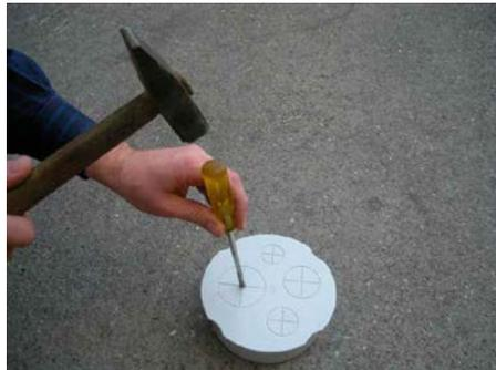
2. Die passenden Verschraubungen je nach Anzahl und Durchmesser der gewünschten Rohre/Leitungen auswählen und die Sollbruchstellen öffnen
