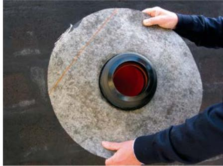
2. Bitumenkragen aufsetzen ...
