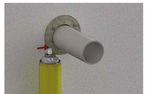
12. Hohlraum zwischen Anschlussrohr und Fassade mit PU-Schaum auffüllen
