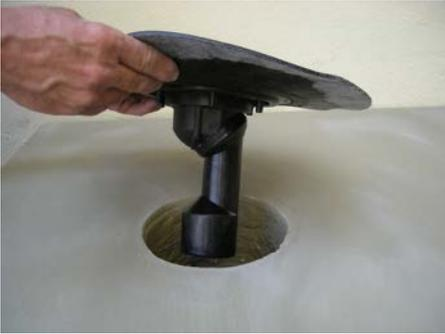
1. Ablaufkörper mit Bauschutz in den Deckendurchbruch einlegen
