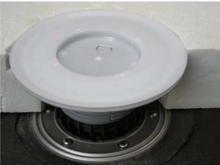
4. Aufstockelement mit Dichtflansch (HL85N) ablängen und an die Höhe der Wärmedämmung anpassen, auf den Entwässerungsring (HL180) aufsetzen, Bauschutz auflegen
