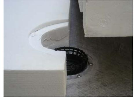
3. Trennlage auflegen, Entwässerungsring (HL180) auf den Ablaufkörper aufsetzen, Wärmedämmung anbringen
