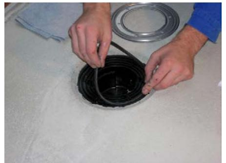
3. Zaštitni poklopac otkloniti, prirubnicu očistiti i postaviti dihtung u predviđeno udubljenje
